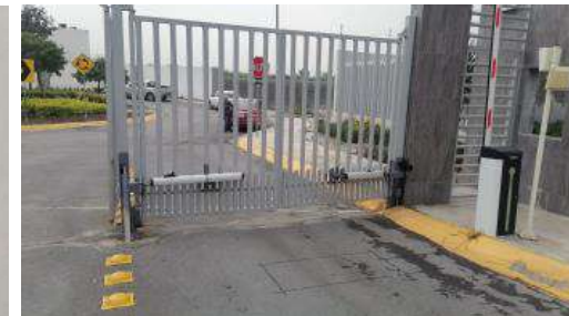
Pistones nuevos instalados...
