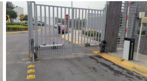
Pistones nuevos instalados...
